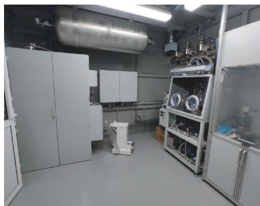
(б) после монтажа
